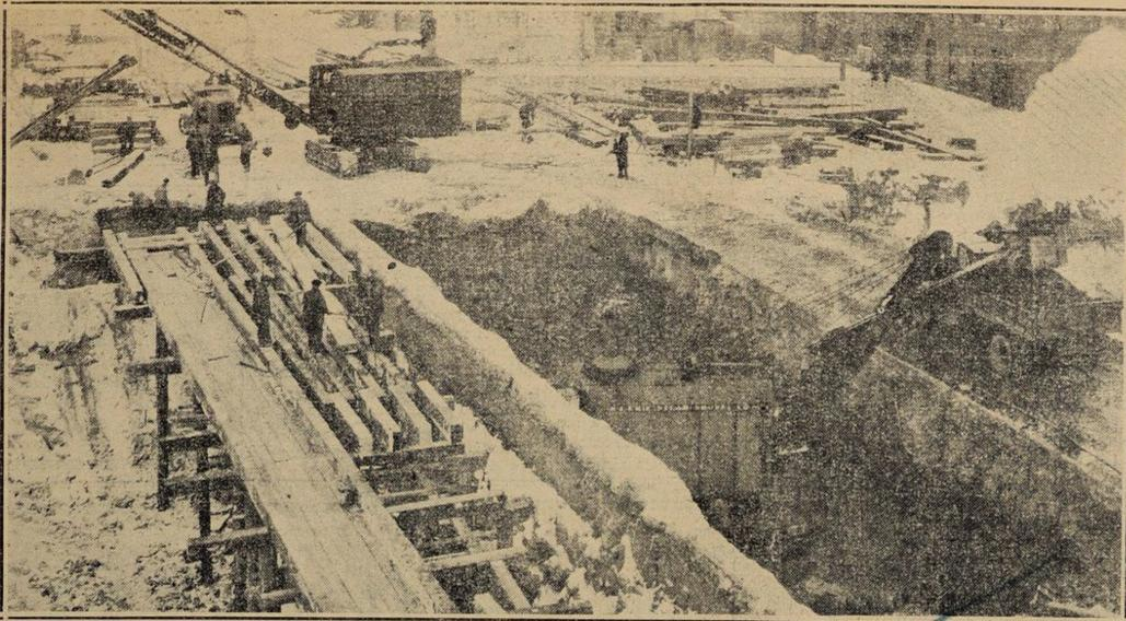
I lavori per la costruzione della nuova stazione terminale della C. N. R. progrediscono rapidamente. La nostra fotografia mostra un ponte temporaneo costruito sulla strada Lagauchetière.
