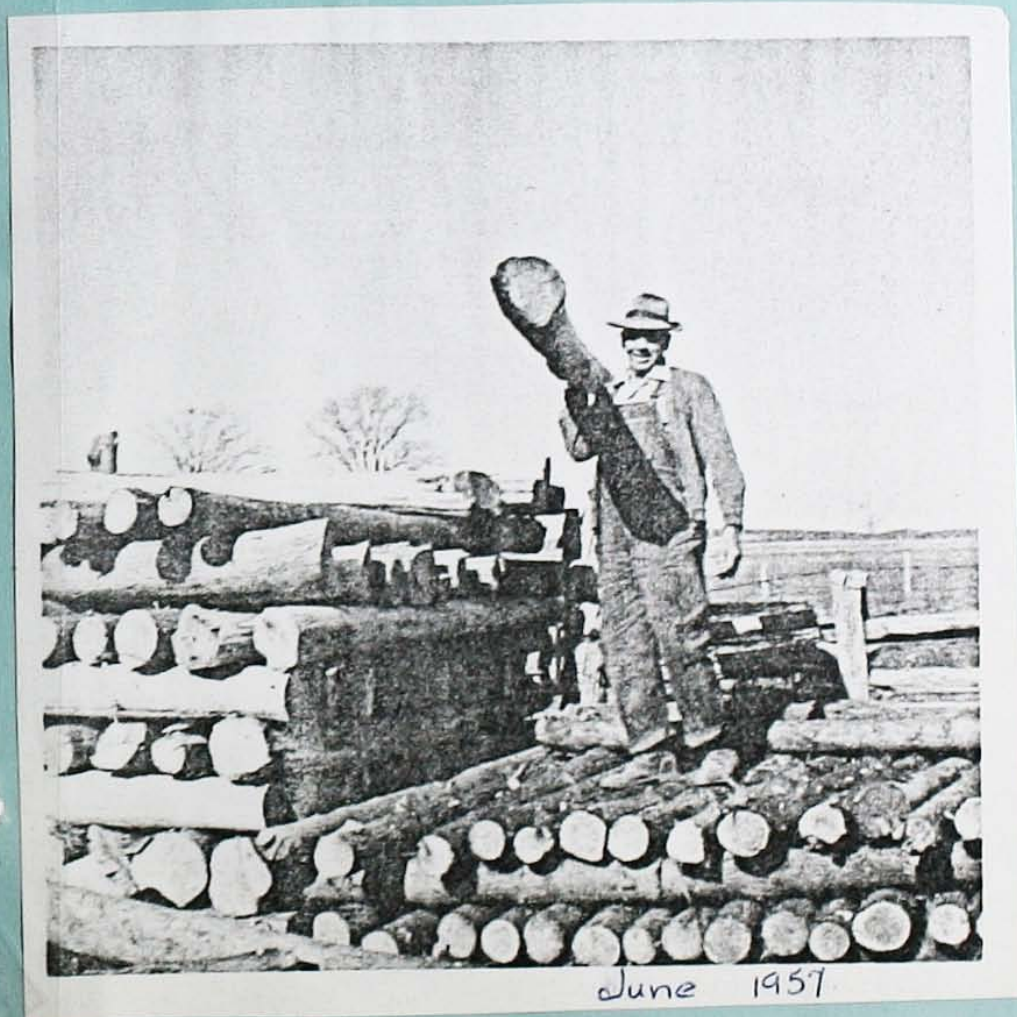
Earl Siegner Piling Posts
