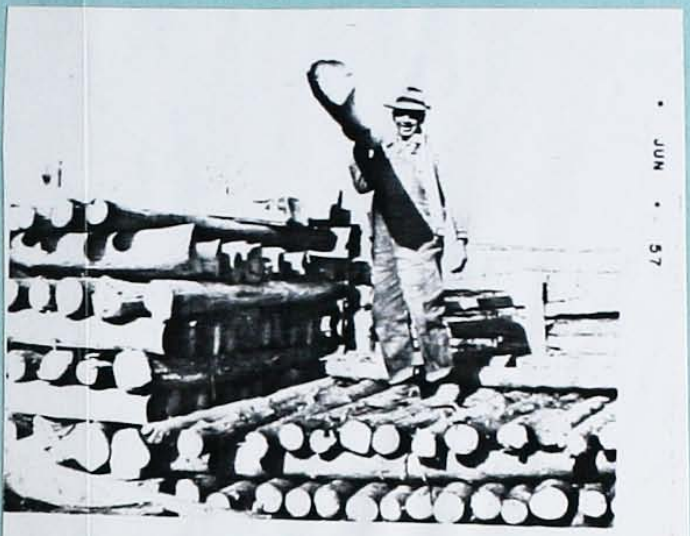
Earl Siegner piling posts
